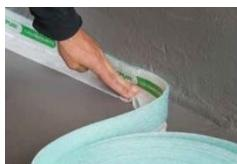
Kantisolering til minikombitoppladen og kombitopplader uden isolering. Kantbåndet består af isolerings strimmel og med dobbeltklæben tap til fastholdelse til gulvet. Mini Kombitoppladen er med lim og skal sættes direkte ned båndet. Ellers skal der fuges ellers limes imellem pladen og båndet.
