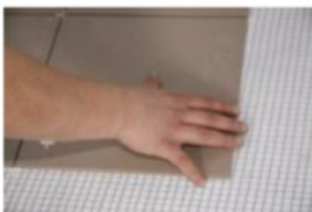
Montering af fliser som slutgulv
