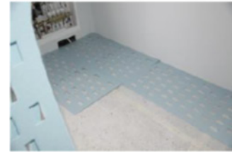
Udlægning af fundament til flydende gulv (kun efter behov)
