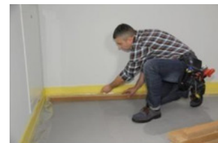
Udlægning af fiber kantprofil
