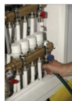
Rensning af rør, påfyldning af system og trykprøvning
