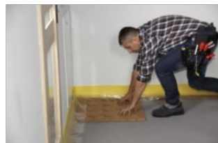
Udlægning af multiplader
