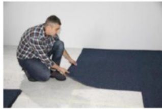
Udlægning af gulvtæppe som slutgulv
